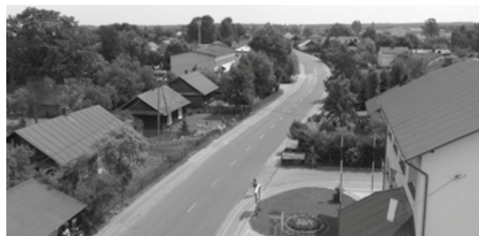
Fragment przebudowanej drogi Jarocin – Krzeszów
