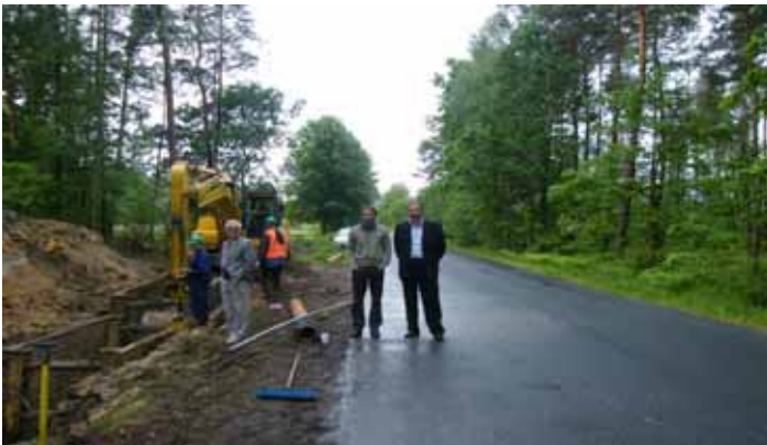
Wizyta na budowie konsultanta z Cross Czech a.s.
